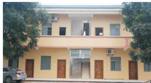
图为办公楼修缮后
