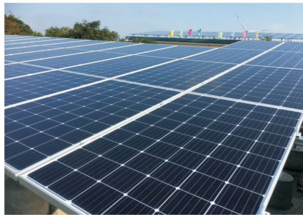
图为光伏发电项目建设中
