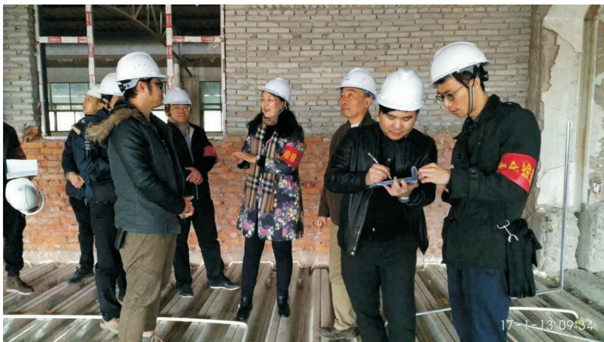
图为集团公司白涛董事长、花红林副总经理带队检查施工现场
