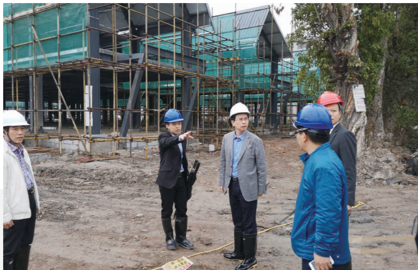
2019年2月，集团党委副书记、总经理戴智到工美港园区进行安全生产调研和检查
